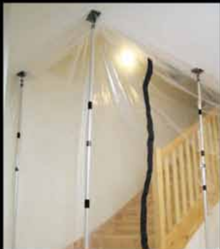
Renovering av trappa
