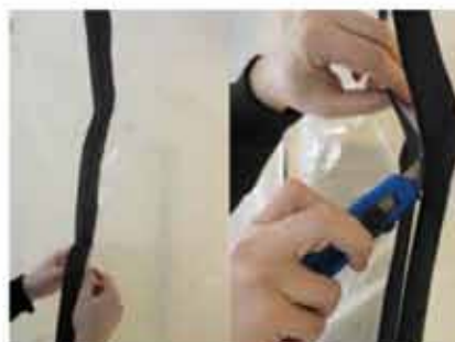
För att skapa en passage: fäst det självhäftande blixtlåset på önskad plats. Öppna dragkedjan och skär därefter ett snitt i täckplasten.
