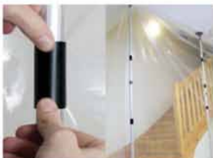
Använd U-Clipsen för att fästa täckplasten mot stöttorna.
