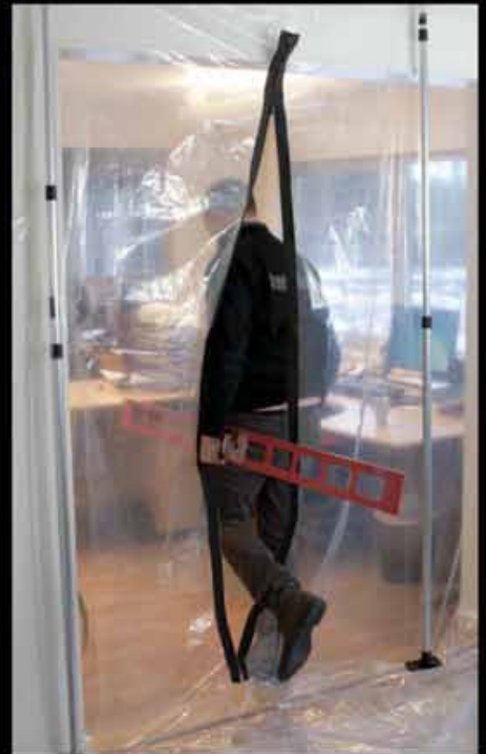
Renovering av kontor
