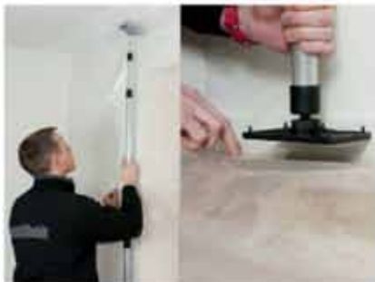
Res upp stöttan med den fjädrande delen mot taket. Börja i ena änden och res stöttorna varrefter.
